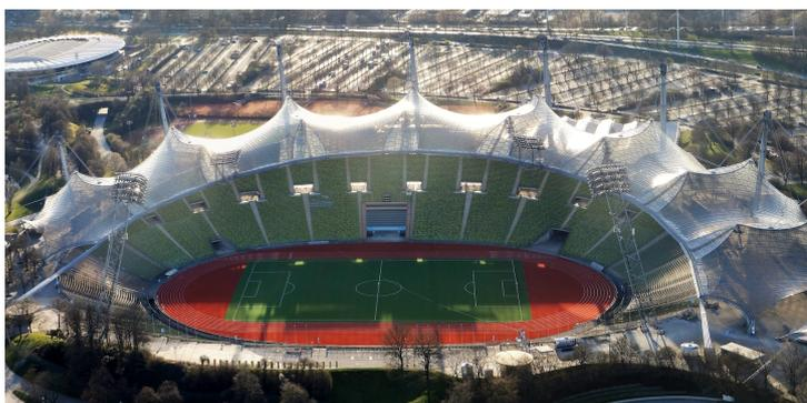
Figura 5: Cubierta con membranas y cables, estadio olímpico de Munich, 1972
